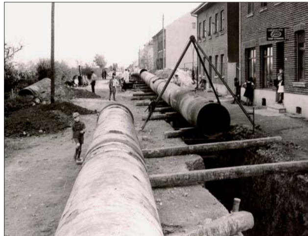
Bau einer Wassertransportleitung um 1955
