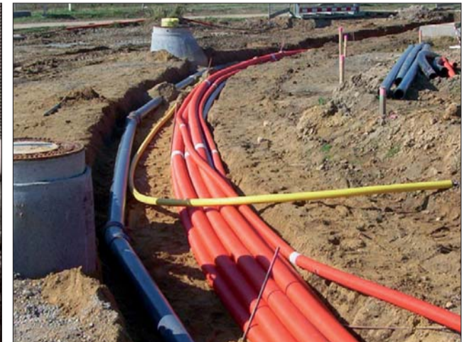
Netzbau heute: gemeinsame Verlegung mehrerer Sparten
