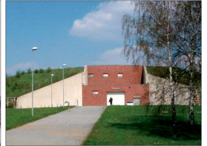
Behälter Gottesseggen heute, Neubau 1997/98
