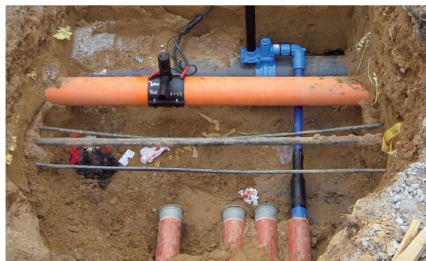
Neubau eines Hausanschlusses
